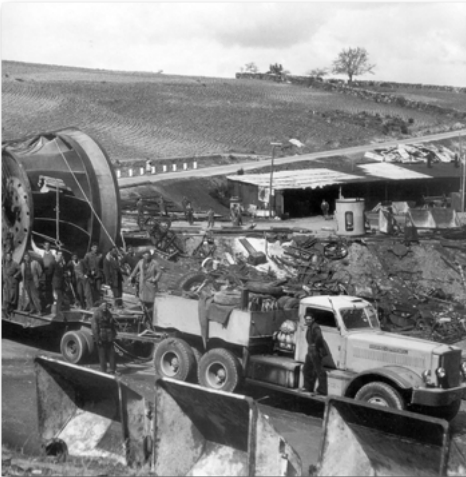
Traslado de maquinaria para la central hidroeléctrica de Castro (Zamora), que entró en servicio en 1952.
