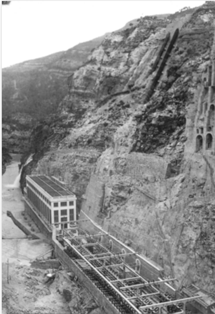
Vista general de la central hidroeléctrica de Millares (Valencia), inaugurada en 1933.
